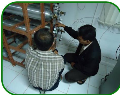
Agar mencegah terjadinya kontaminasi dari udara dilakukan proses flushing setelah pemasangan regulator
