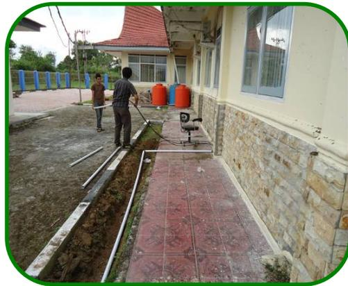
Pemasangan kabel pendukung dan memasukkan kabel dalam pipa PVC
